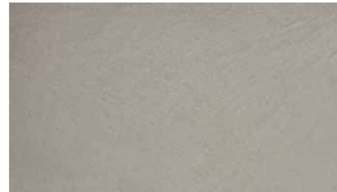
PANDOMO® Loft Bodenfläche behandelt mit: PANDOMO® SP-CEE 2-K Polyurethanemulsion, PANDOMO® SP-PS Wässrige Polyurethan-Versiegelung und PANDOMO® SP-GS Seidenglanz-Siegel
